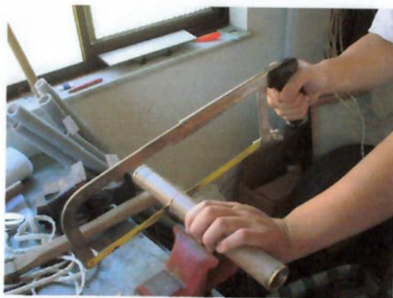
Figura 11.15 - Corte do tubo de 1 polegada
