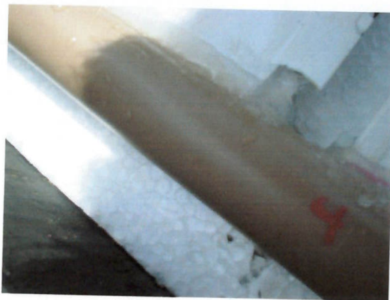
Figura 12.4 – Detalhe do vazamento sob o cordão de silicone
