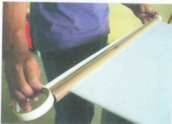
Foto 11: Fita crepe para proteção na pintura
