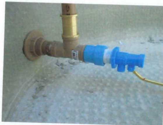
Figura 11.6 - Detalhe da válvula fria do coletor de água (protótipo)
