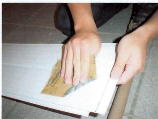
Figura 11.44 - Tratamento da superfície do forro
