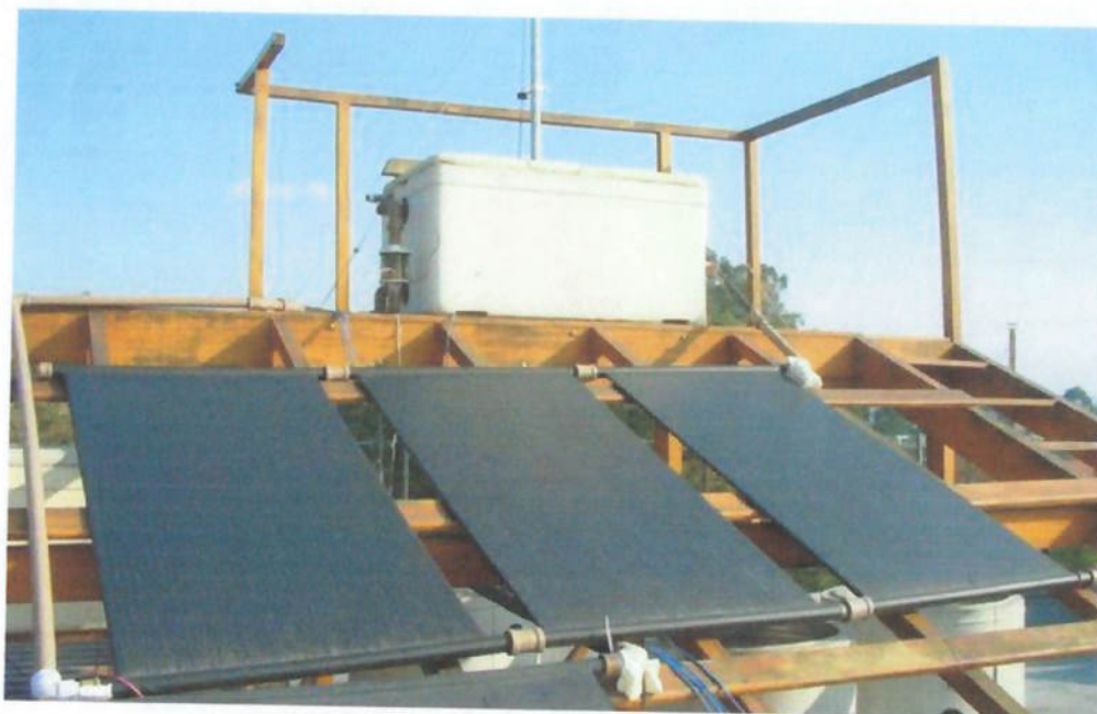
Figura 8.1 – Coletor solar plano de PVC
