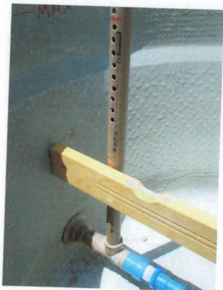
Figura 11.9 - Marcação da posição do anteparo no tubo do coletor de água quente
