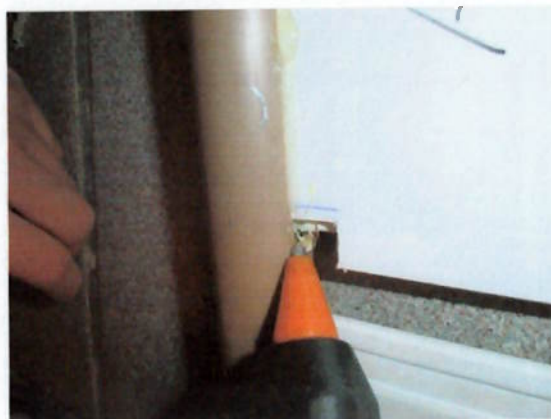
Figura 11.54 - Vedação das extremidades
