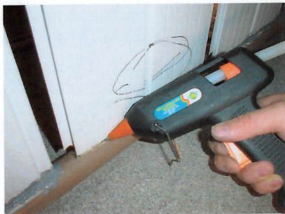
Figura 11.53 - Aplicação com pistola de silicone
