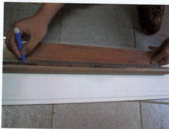
Figura 11.35 - Marcação da linha de centro
