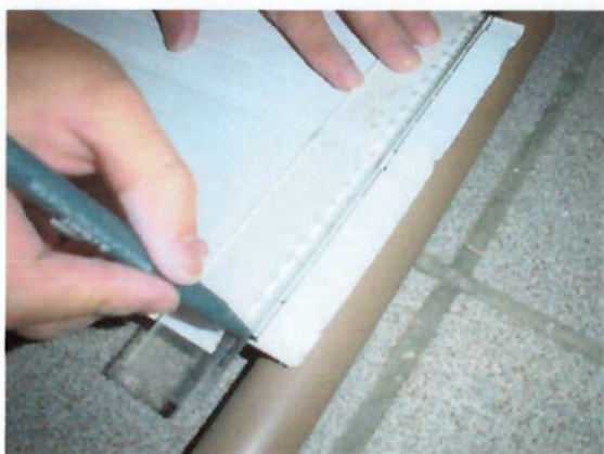
Figura 11.43 - Marcação da linha de profundidade
